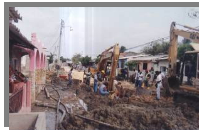
IMPACTOS DURANTE LA CONSTRUCCIÓN
